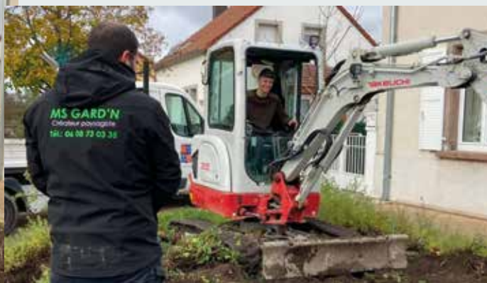
PRÉPARATION DES PLATES-BANDES RUE DE SARREGUEMINES
